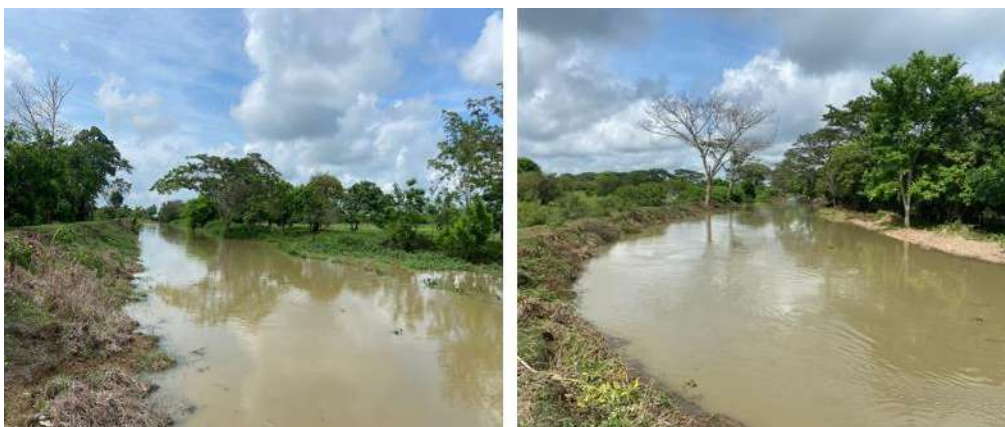
Ilustración 18. Tramo de caño intervenido posterior a labores de limpieza y rocería. Fuente: CVS, 2023
