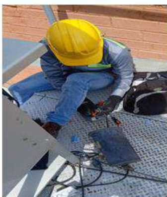
Mantenimiento equipos SVCA
