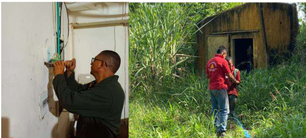
Ilustración 231. Mantenimientos eléctricos en la Estación Piscícola. Fuente: CVS, 2023
