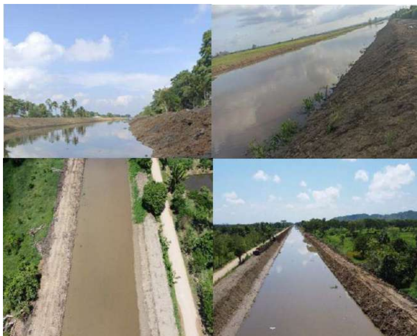
Ilustración 20. Ampliación de la Sección y conformación de terraplenes. Fuente: CVS, 2023
