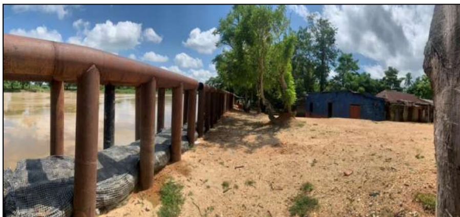
Ilustración 151. Registro fotográfico Obra de mitigación y protección de la margen derecha del río San Jorge, en el corregimiento Marralú, municipio de Ayapel. Fuente: Grupo de Gestión del Riesgo – GGR CVS, 2023.
