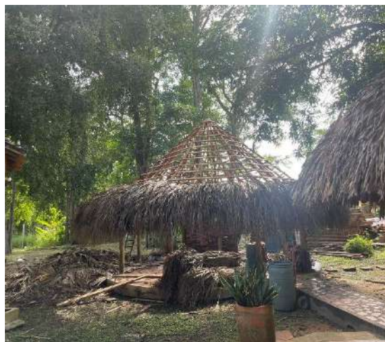
Ilustración 252. Sede Mocari - Montería
